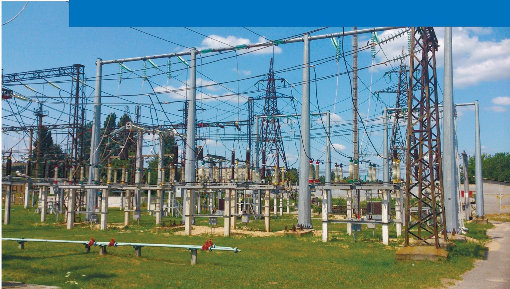
Застосування багатогранних опор та порталів є оптимальним рішенням у реалізації програми модернізації мереж та підстанцій в енергосистемі України.
